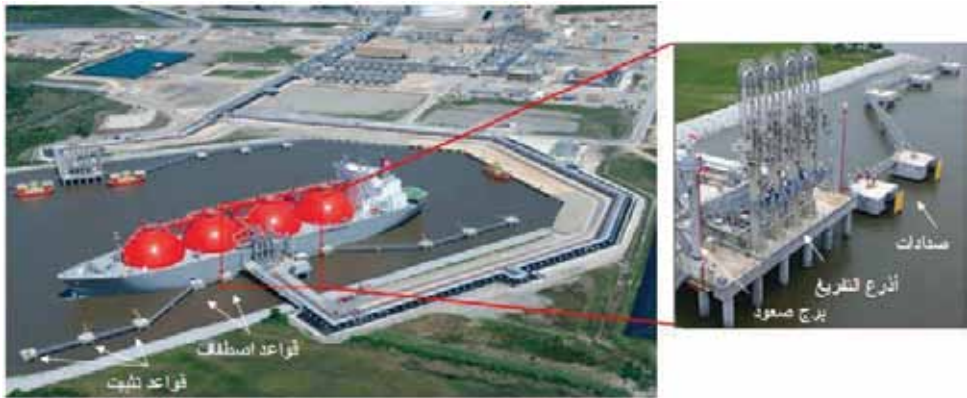
الشكل 10-1: رصيف الاستقبال في مرفأ Sabine Pass LNG بالولايات المتحدة
